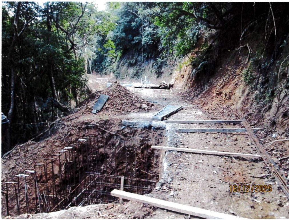
照片四(OK+430 公所災修工程)
