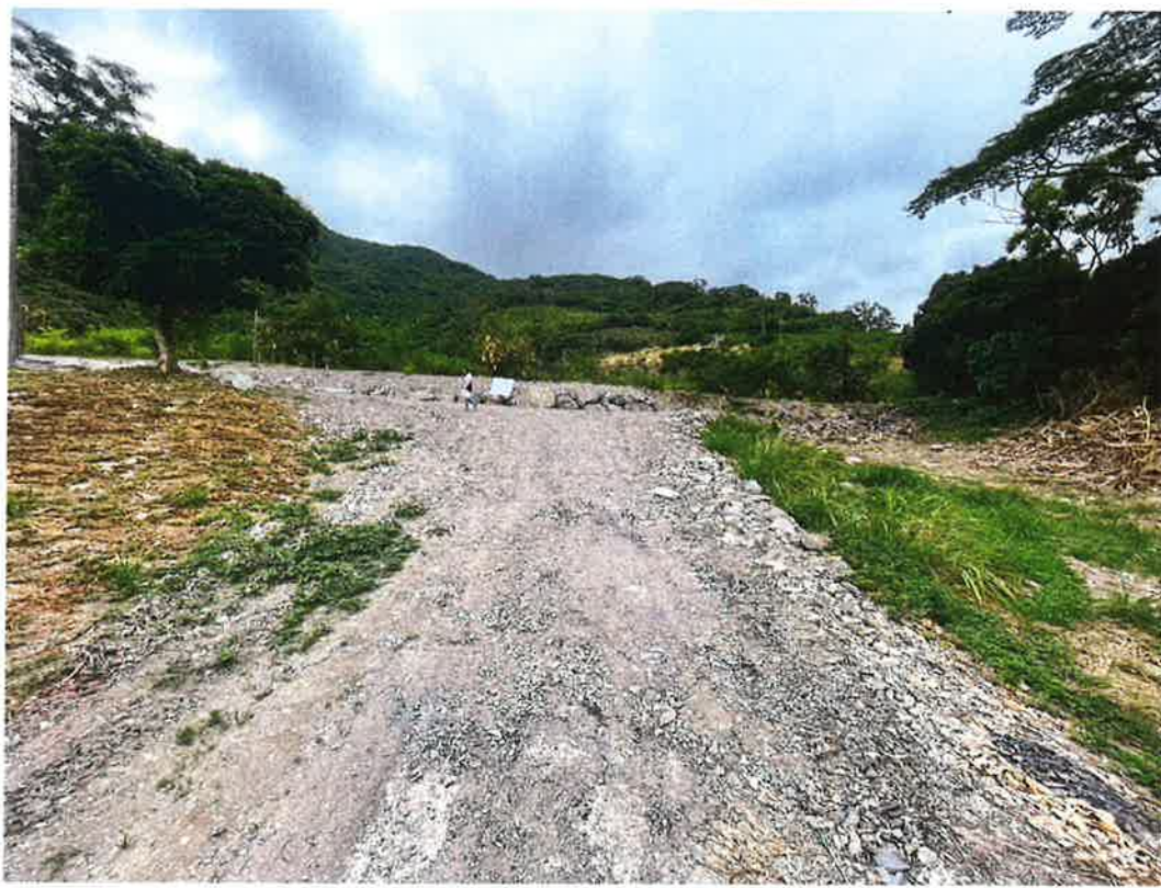
照片一-第一工區
