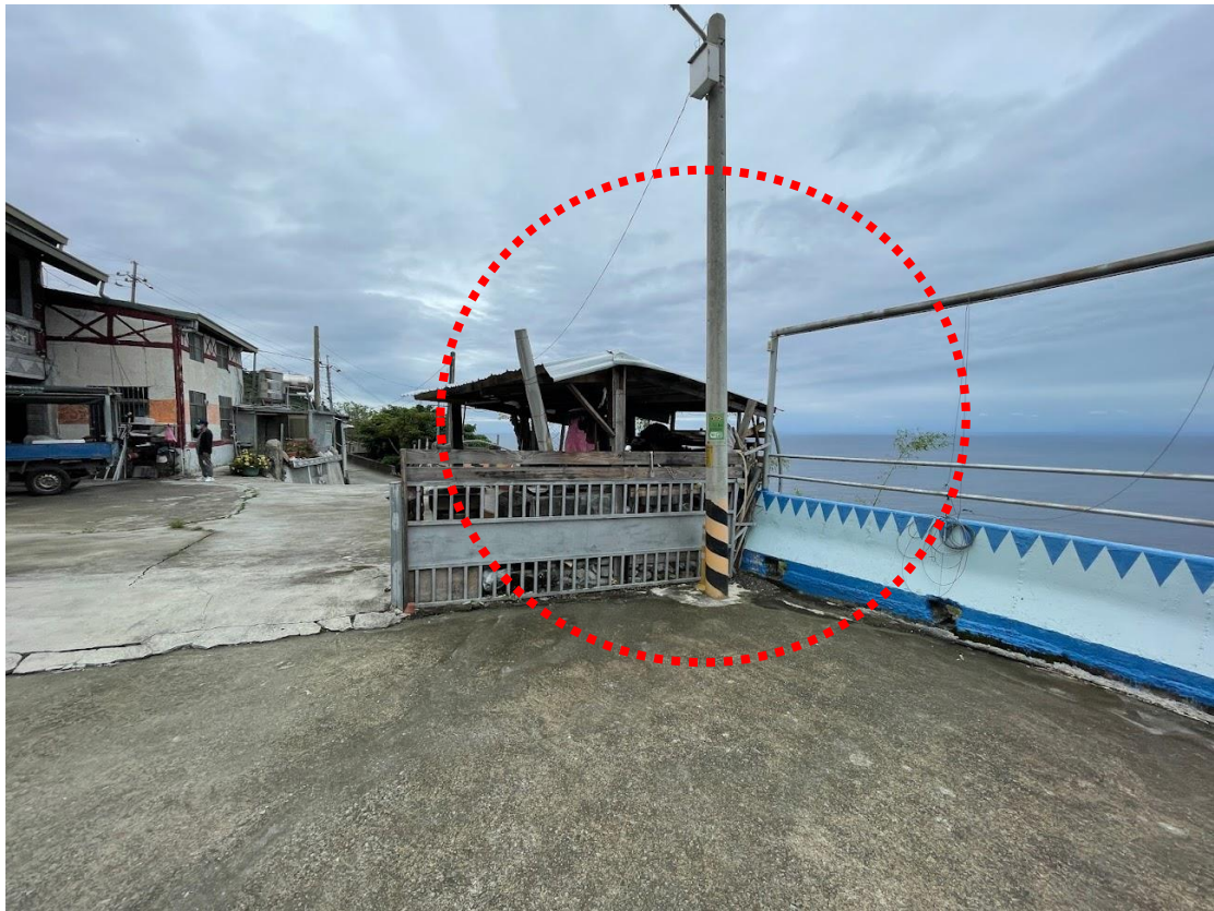
圖 4. 工區 2(天主堂旁桿線)請太麻里鄉公所協助遷移
