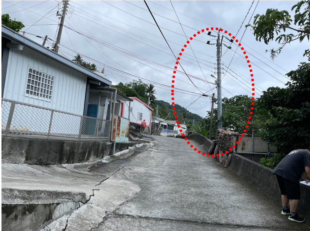
圖 3. 工區 2 電桿現況照(建請台灣電力公司協助遷移)
