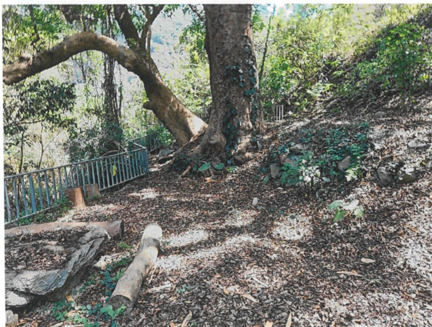
工區 B 既有護欄現況仍良好
