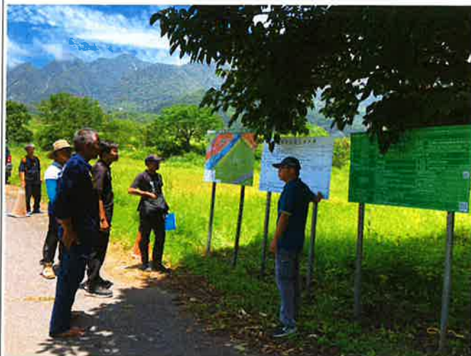
說明：中游工區施工前協調會
