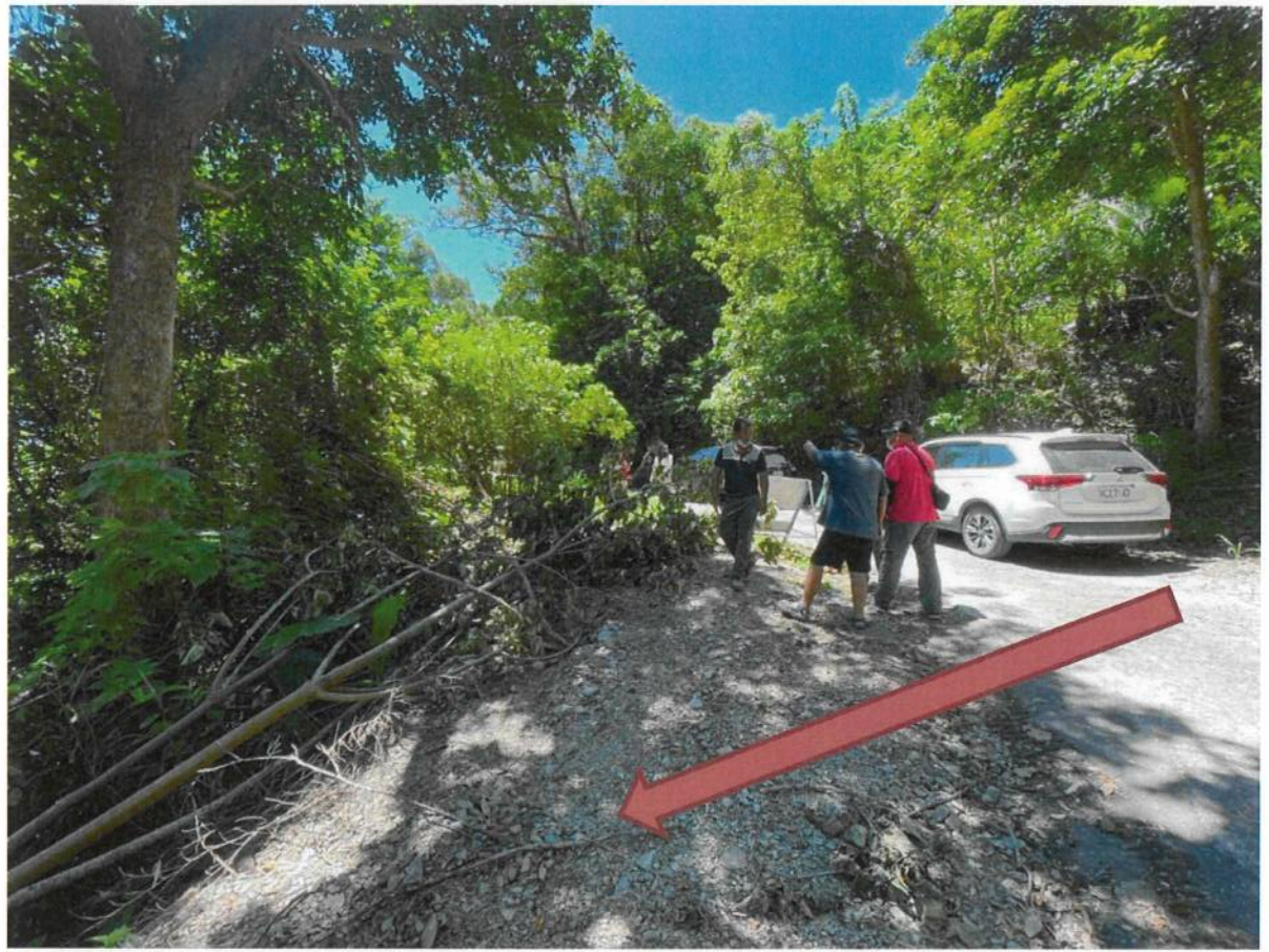
0K+163 新設橫向排水設施現況相片(五)
